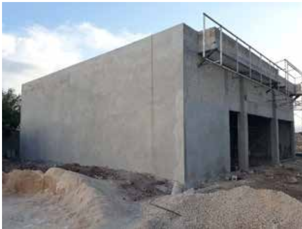
Construcción Local Comercial (Cielo Alto), Kanasin, Yuc. 2018 CREAR ESPACIOS
