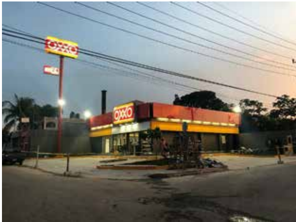
Construcción de tienda OXXO (COLONOS), Valladolid, Yuc. 2019
