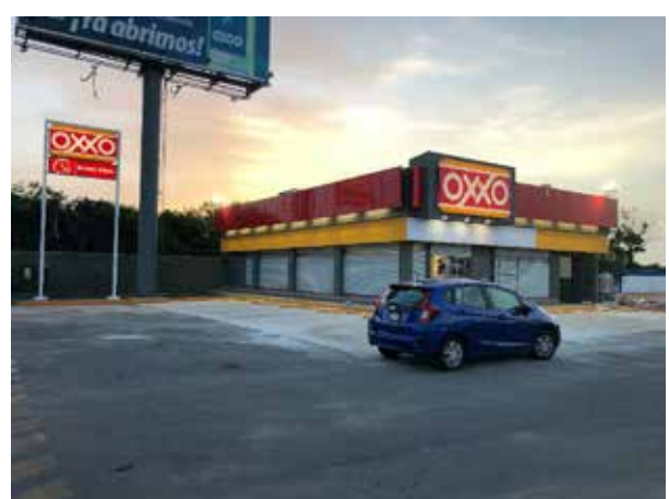
Construcción de tienda OXXO (GAS TETIZ), Mérida, Yuc. 2019 OXXO
