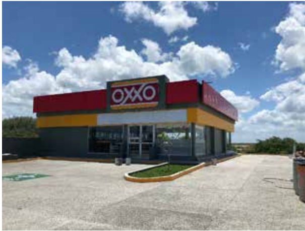
Construcción de tienda OXXO (COSTERA), Chicxulub, Yuc. 2018 OXXO
