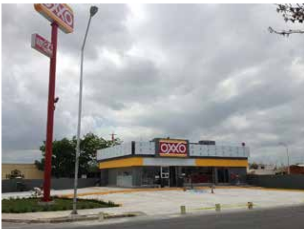
Construcción de tienda OXXO (Girasoles), Mérida, Yuc. 2013
