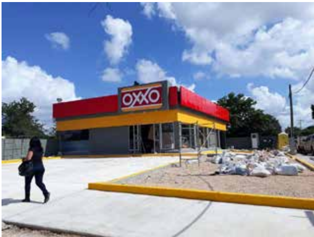
Construcción de tienda OXXO (NUBES), Mérida, Yuc. 2017
