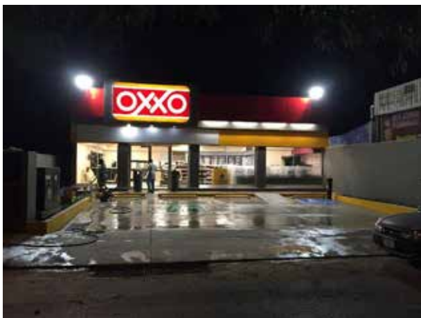
Construcción de tienda OXXO (CEIBA), Mérida, Yuc. 2017
