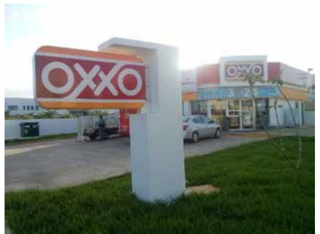
Construcción de tienda OXXO (MONTEBELLO), Mérida, Yuc. 2016
