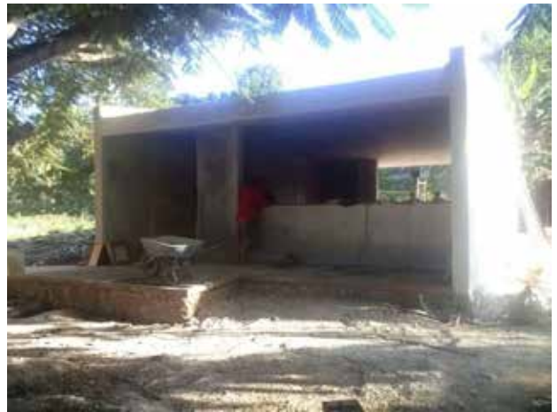
Construcción de 1 aulas en Peto, Yuc. 2014 IDEFEY
