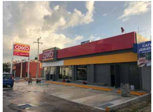
Construcción de tienda OXXO (UP TOWN), Mérida, Yuc. 2019
