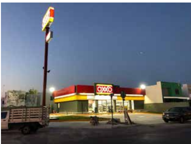
Construcción de tienda OXXO (LA QUINTA), Mérida, Yuc. 2019 OXXO
