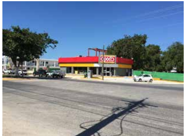
Construcción de tienda OXXO (ESPECIALIDADES), Campeche, Campeche, 2017
