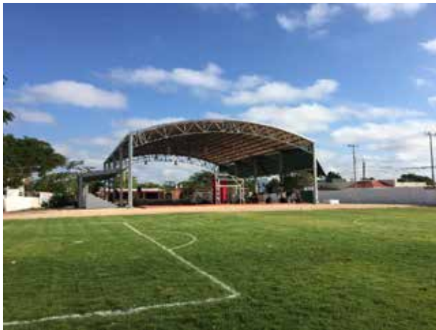
Construcción de cancha de usos múltiples y campo de fútbol en la escuela secundaria "Adolfo Cisneros Cámara", Mérida, Yuc. 2014/INCCOPY
