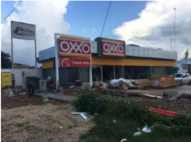
Construcción de tienda OXXO (MOTULEÑO), Motul, Yuc. 2017
