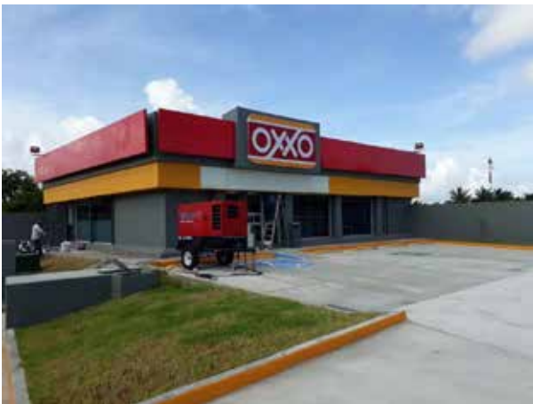
Construcción de tienda OXXO (CHUBURNA PUERTO), Chuburna Puerto, Yuc. 2020
