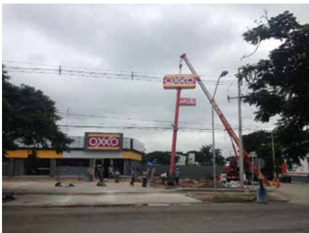
Construcción de tienda OXXO (PEDREGALES), Mérida, Yuc. 2014
