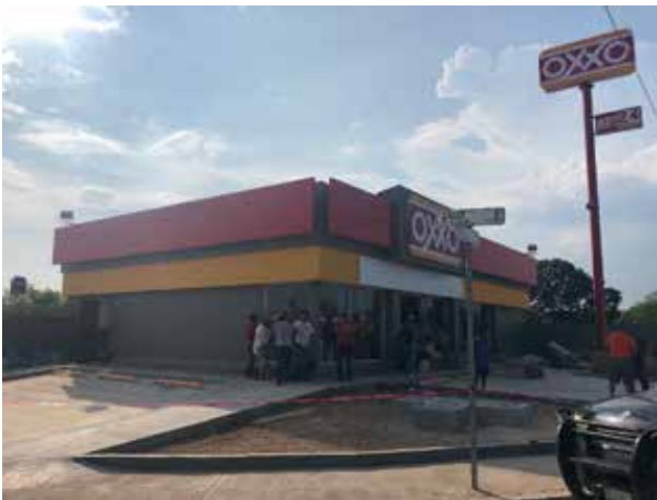
Construcción de tienda OXXO (REAL KANASIN), Kanasin, Yuc. 2019
