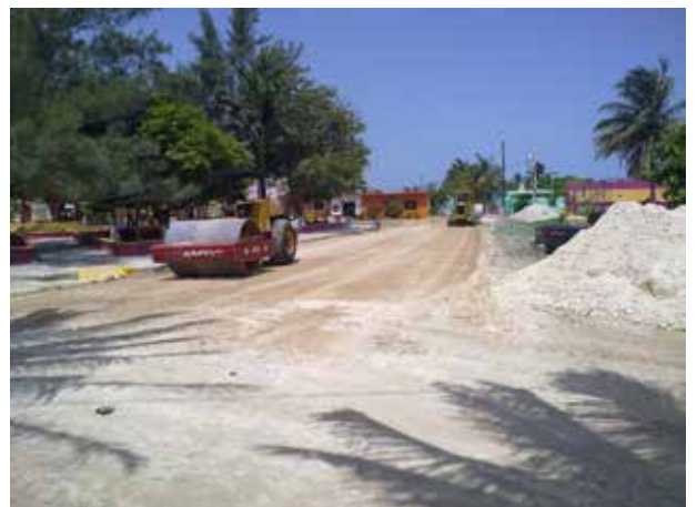
Construcción de Calles de Sisal, Yuc. 2011 INCA Y
