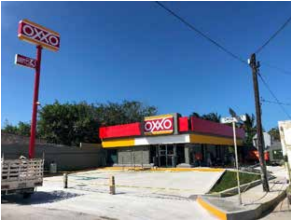
Construcción de tienda OXXO (PLAYA SOL), Progreso, Yuc. 2020
