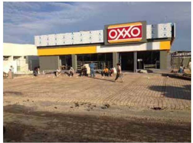
Construcción de tienda OXXO (Marina), Progreso, Yuc. 2013
