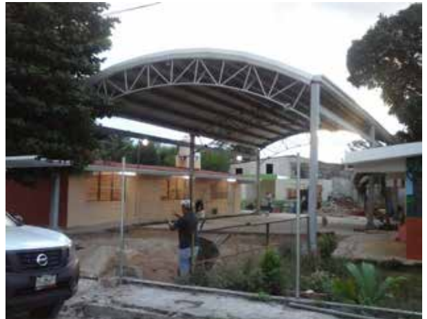
Mejoramiento y construcción de techumbre en preescolar Yucatán, Ticul, Yuc. 2016
