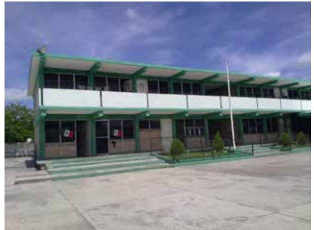
Rehabilitación General del Plantel "Primaria Alfonso Urueta Carrillo", Mérida, Yuc. 2011 IDEFEY
