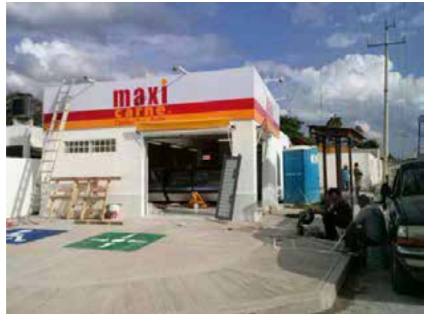
Remodelación de expendio La Finca, Kanasin, Yuc. 2016
