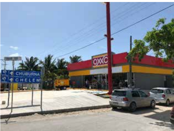
Construcción de tienda OXXO (COSTA AZUL), Mérida, Yuc. 2018
