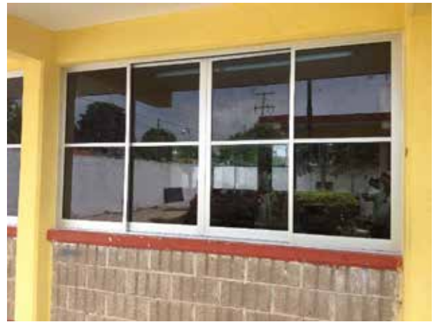
Rehabilitación en la secundaria "María canto de Roche", Izamal, Yuc. 2012
