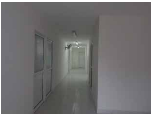
Remodelación Escuela Expendio Central de Abastos Mérida, Yuc. 208 KEKEN
