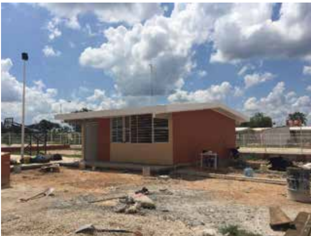
Construcción de un aula didáctica, Umán, Yuc. 2016
