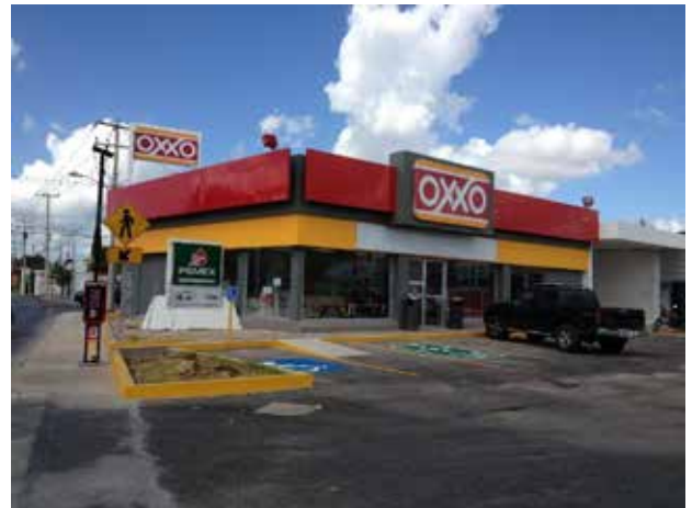
Construcción de tienda OXXO (Chuburna Inn), Mérida, Yuc. 2012
