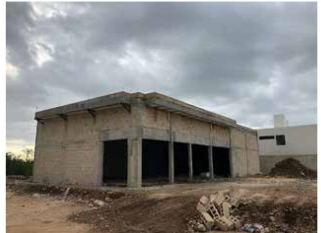
Construcción Local Comercial (OXXO Solana), Tixcacl Opichen, Yuc. 2019
