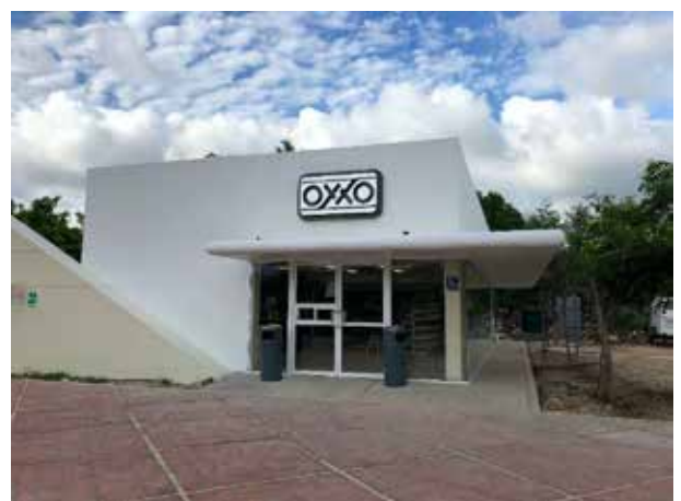
Construcción de tienda OXXO (UADY), Mérida, Yuc. 2018
