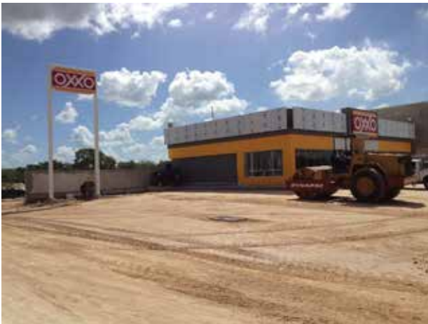
Construcción de tienda OXXO (Teya), Mérida, Yuc. 2012
