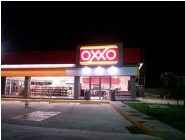
Construcción de tienda OXXO (LA PERLA), Mérida, Yuc. 2015
