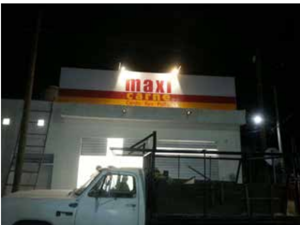
Remodelación de expendio Villas de Oriente, Kanasin, Yuc. 2016
