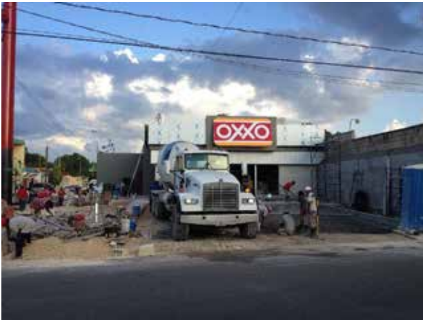
Construcción de tienda OXXO (San Marcos), Mérida, Yuc. 2013
