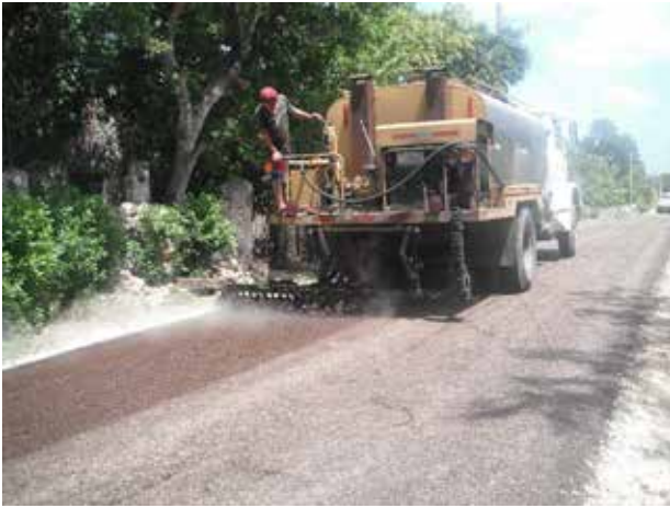
Construcción de Calles en el municipio de Tixkokob, Yuc. 2012
