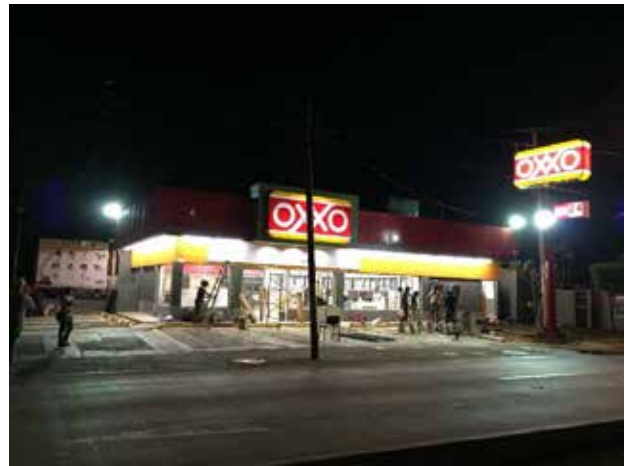
Remodelación de tienda OXXO (TECNOLOGICO), Mérida, Yuc. 2015
