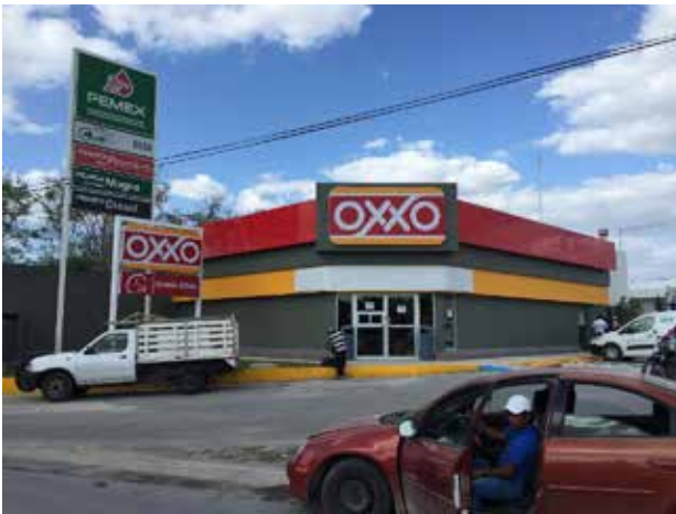
Adecuación de tienda OXXO (JOYA), Mérida, Yuc. 2016
