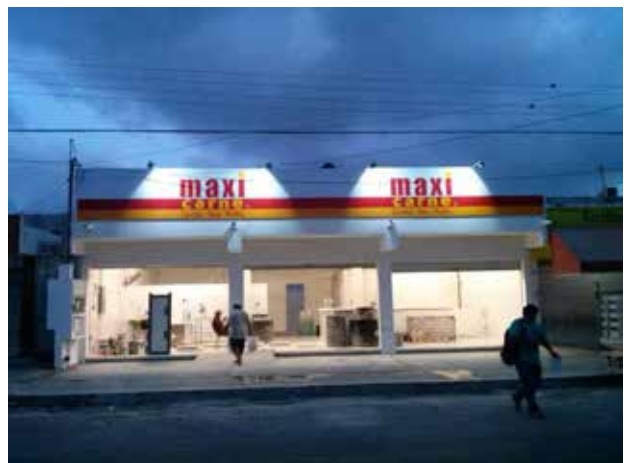
Remodelación de expendio Progreso, Progreso, Yuc. 2017
