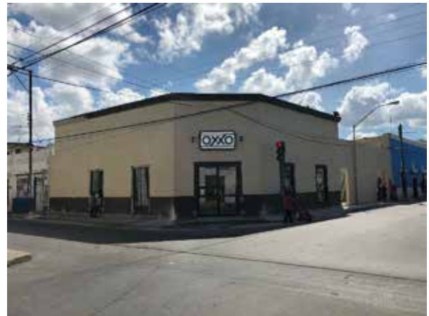
Construcción de tienda OXXO (LAS ALMAS), Mérida, Yuc. 2018 OXXO
