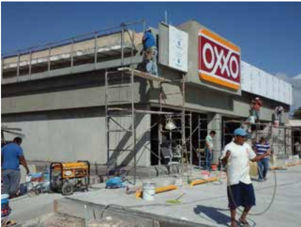
Construcción de tienda OXXO (PASEOS VERDES), Mérida, Yuc. 2016
