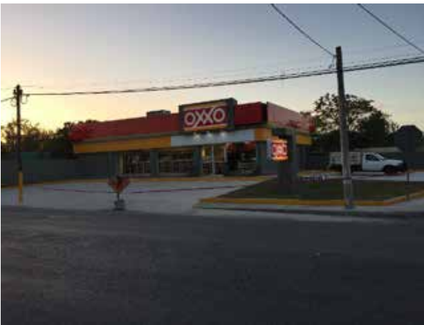
Construcción de tienda OXXO (ORIENTE), Mérida, Yuc. 2018
