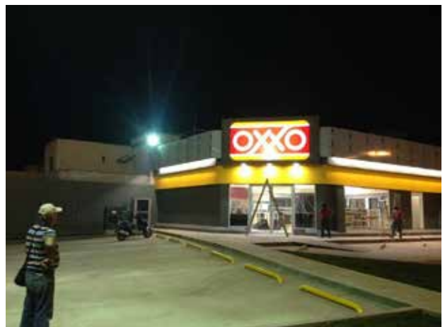
Construcción de tienda OXXO (PILAR), Mérida, Yuc. 2014
