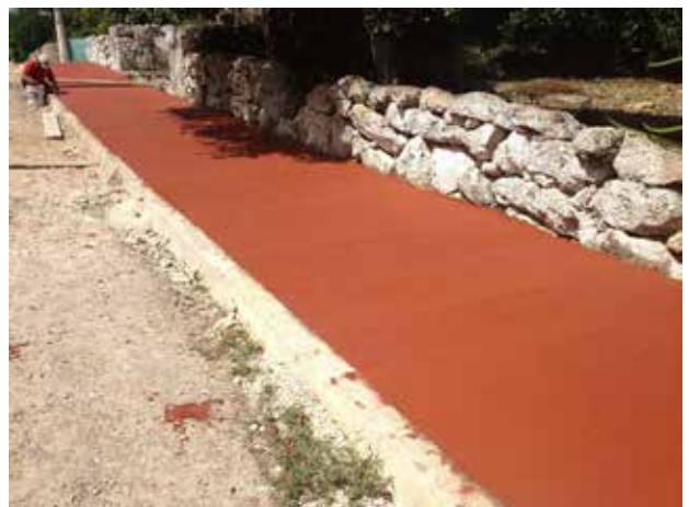
Construcción de banquetas y guarniciones en Kantunil, Yuc. 2012
