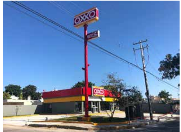
Construcción de tienda OXXO (CENTRITO), Mérida, Yuc. 2020
