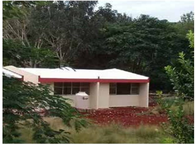
Construcción de 2 aulas en Tinum, Yuc. 2013 IDEFEY
