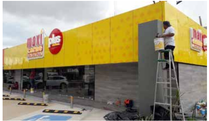
Remodelación de Expendio México Norte, Mérida, Yuc. 2019
