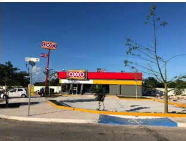
Construcción de tienda OXXO (AMERICAS NORTE), Mérida, Yuc. 2019
