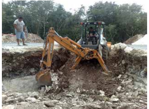
Construcción de pasos de fauna en el km 4+280 y 5+920, tramo 0+000-6+525, Celtun, Yuc, 2010 INCA Y
